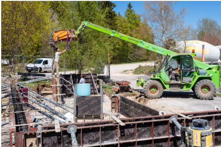
Chantier du chalet des randonneurs, avril 2026
