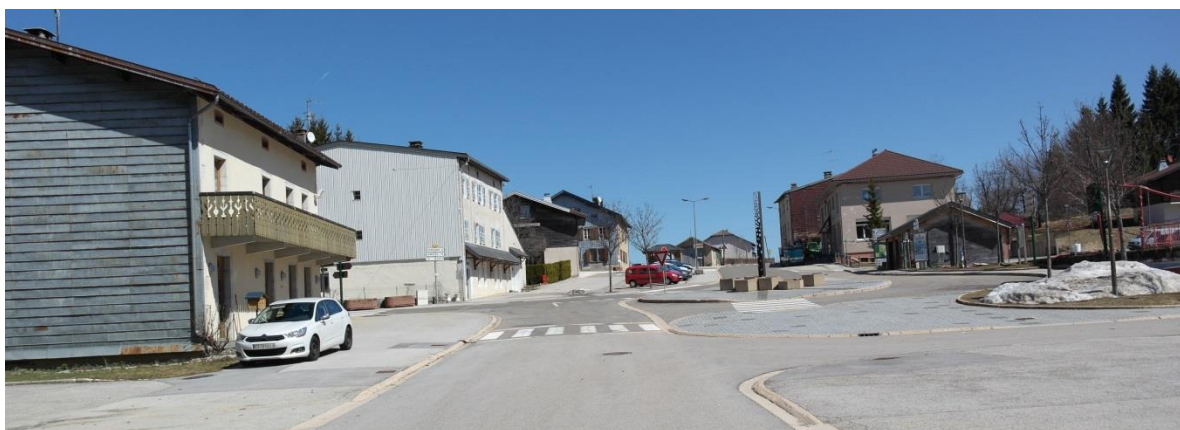
Trottoirs et stationnements se confondent sur un espace ouvert potentiellement qualitatif. La voirie occupe une place extrêmement importante. L'absence de mobilier urbain, marquage au sol ne permettent pas le partage des usages.
